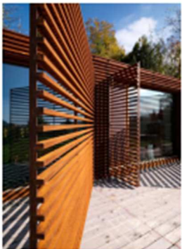
Source : constructionbois.fr A gauche : un brise soleil vertical, à droite un brise soleil horizontal.
