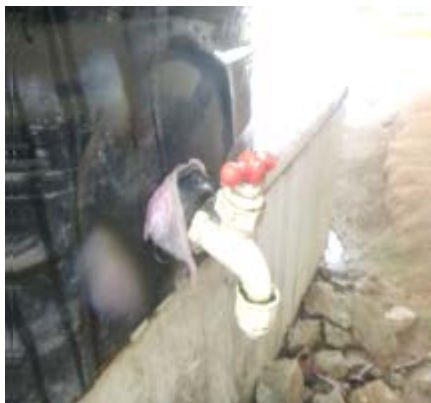
Tuff tank mauvais état, rustures métalliques
