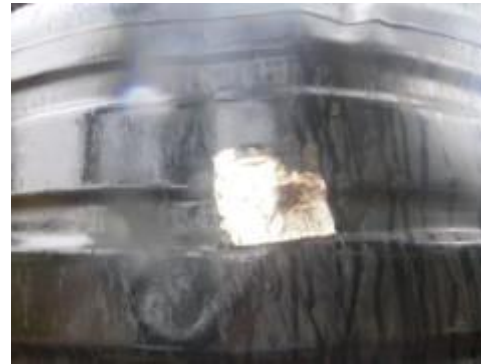
Tuff tank mauvais état, rustines métalliques
