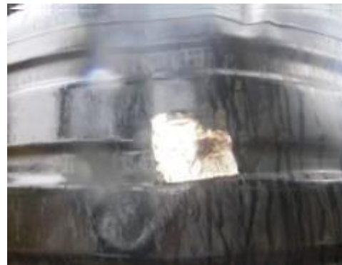
Tuff tank mauvais état, rustines métalliques
